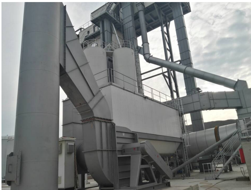
图 3.1-1 (b) 沥青混凝土生产区照片
