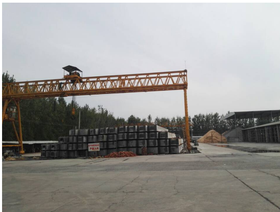
图 3.1-1 (a) 桥梁生产区照片
