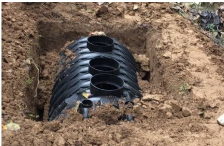
图 4.2-1 化粪池安装照片
